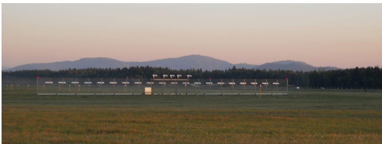
Sl. 9.3 Antene oddajnika za določanje pristajalnega kurza na brniškem letališču.
