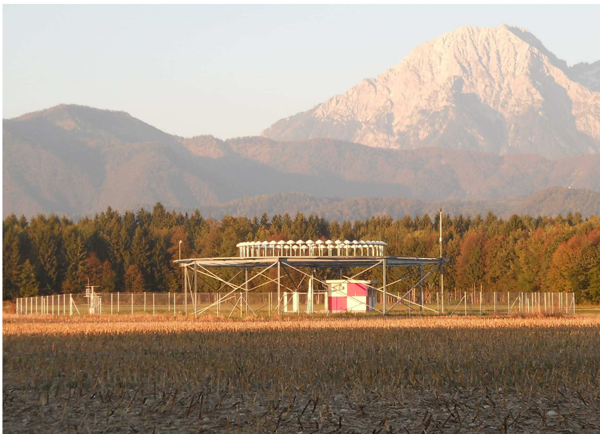
Sl. 6.13 Oddajna antena sistema DVOR brniškega letališča pri Šenčurju
