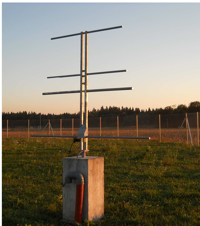
Sl. 9.6 Označevalnik sistema ILS letališča Brnik
